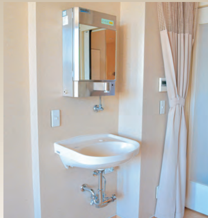
細菌・ウイルスに加えてパイジエロンもカットする限外ろ過膜内蔵の個室手洗い装置
