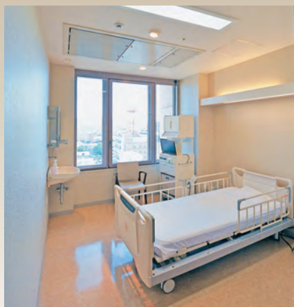
天井のHEPAフィルターパッケージエアコンによる空気清浄度 10, 000のクリーンルーム
